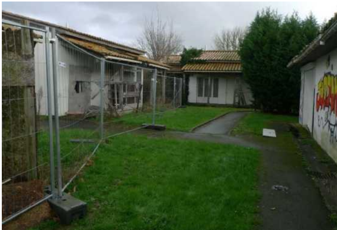
Le quartier poursuit sa mue : après les 44 pavillons en bois construits au Pont Neuf et la réfection de Libération III, ces 43 logements vides vont être détruits. PHOTO ARCHIVES D. B.
